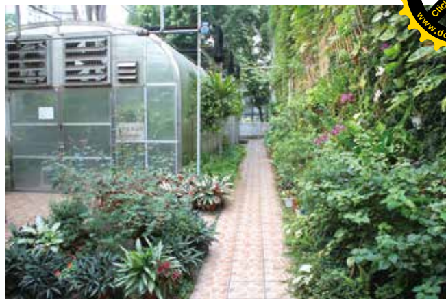
環控水簾溫室
